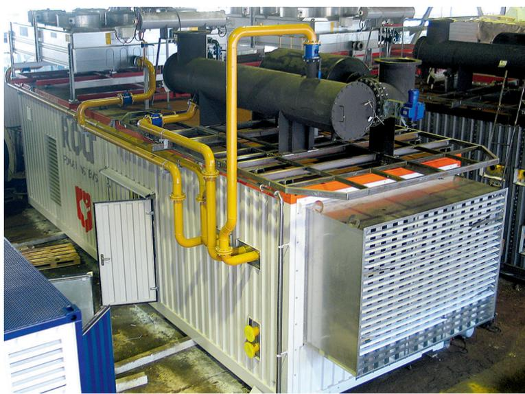
ной мощностью 2000 кВт (эл.) и 1900 кВт (тепл.) с генератором 6,3 кВ. Система автоматического управления ГПУ ROLT power manager RPM-01, реализованная на базе свободнопрограммируемых контроллеров ComAp, обеспечивает автоматический прием/сброс
